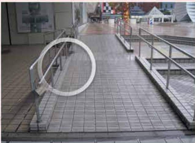
مناسب سازی شده: وجود میله های حفاظتی
